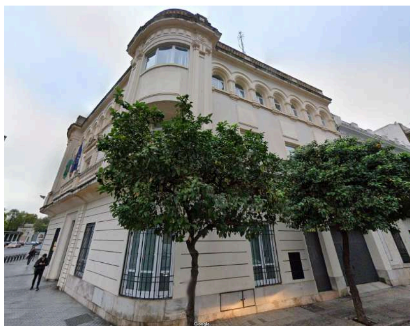
Imagen del edificio desde la esquina entre avenida de los Mozárabes y calle Arfe.
