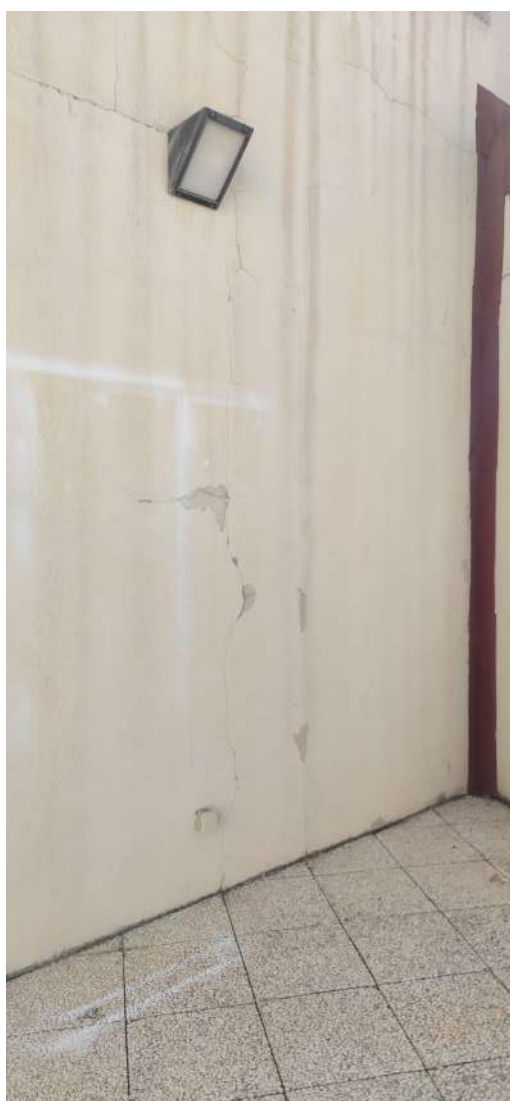
Fisuras puntuales en el revestimiento de la fachada interior de planta 2º.
