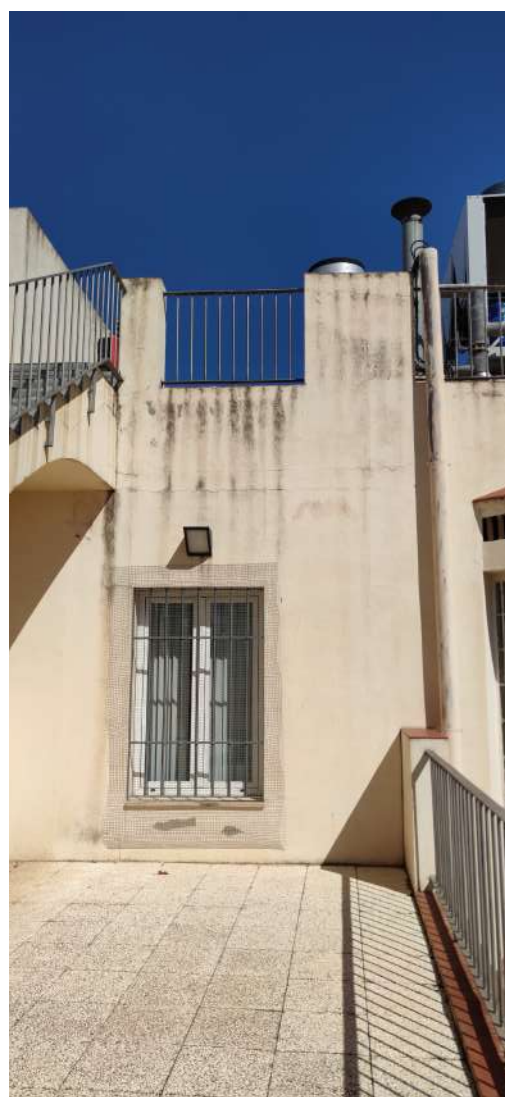
Fisuras puntuales en el revestimiento de la fachada interior de planta 2º.
