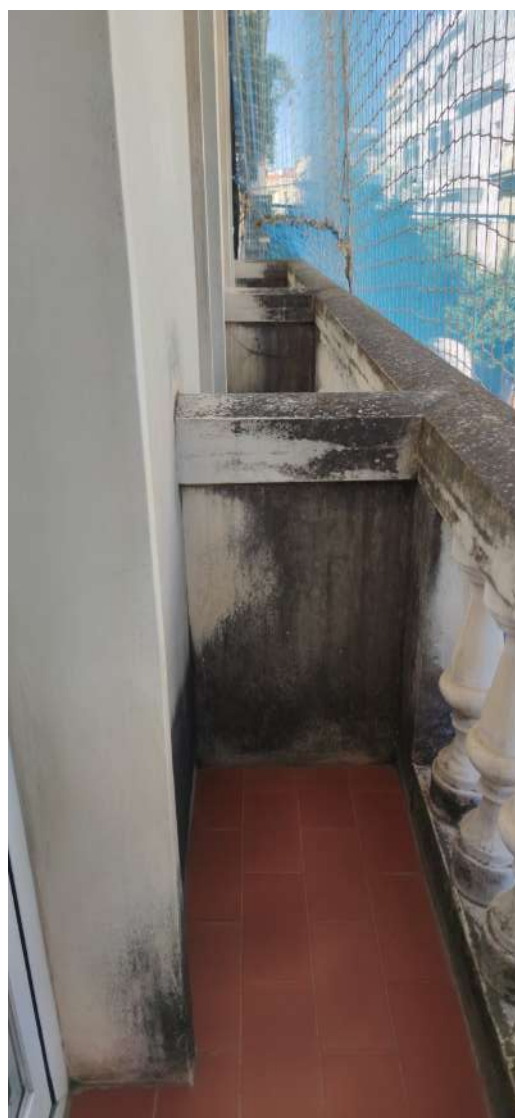
Izquierda: Fachada interior de patio a calle. Se aprecian fisuras superficiales y manchas de moho y humedad.
