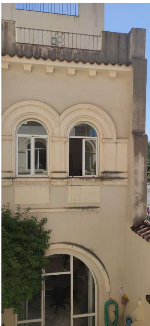
Izquierda: Fachada interior de patio a calle. Se aprecian fisuras superficiales y manchas de moho y humedad.
