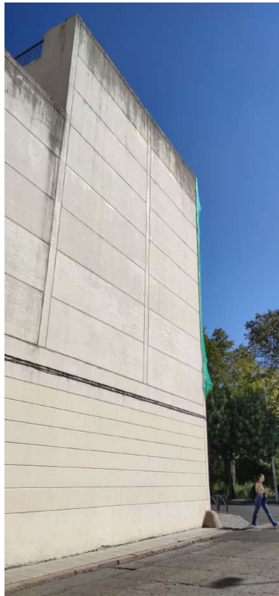
Fachada trasera. Zócalo con humedad por capilaridad y contacto con terreno. Enfoscado con fisuras y manchas de moho.
