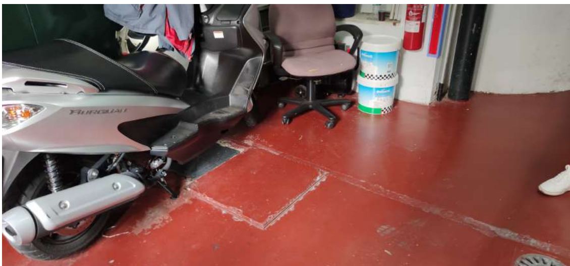
Arqueta de saneamiento existente.
