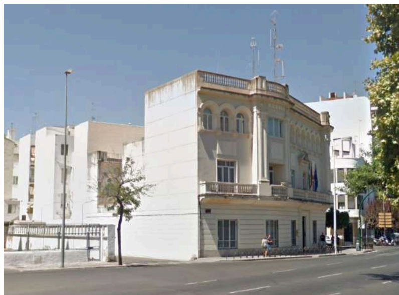
Imagen del edificio desde la esquina entre avenida de los Mozárabes y Paseo de la Victoria. A la izquierda se observa la medianería que construye a la calle de acceso a la Comandancia y uno de los patios de luces.
