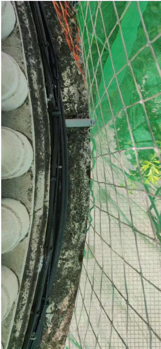
Izquierda: Terraza de oficinas, cornisa de planta baja. Se aprecian manchas de moho y humedad generalizadas. Derecha: Frontón de fachada principal. Se aprecian manchas de moho y humedad y desprendimientos del enfoscado de acabado.
