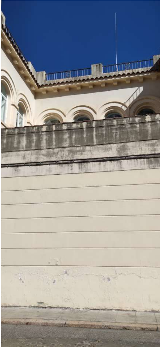
Fachada trasera. Zócalo con humedad por capilaridad y contacto con terreno. Enfoscado con fisuras y manchas de moho.
