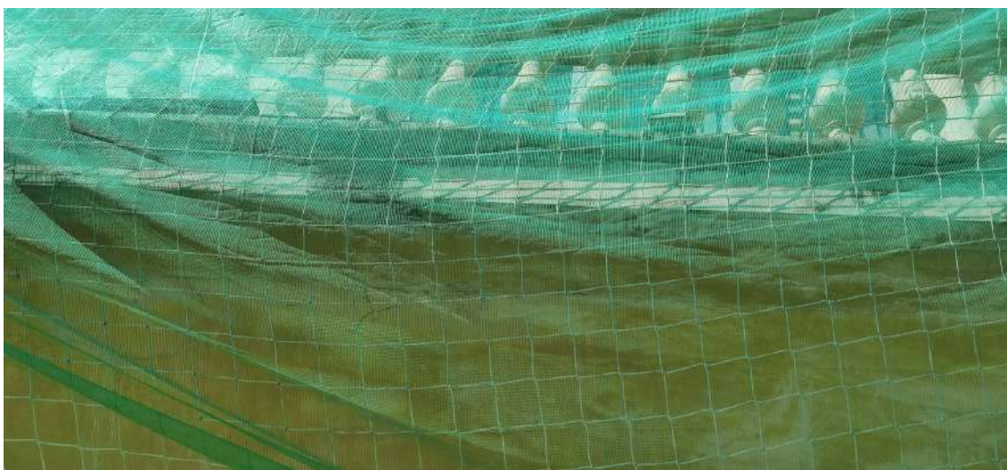
Fisura en cornisa de planta baja.
